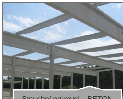
Stavební průmysl – BETON kontrola betonových konstrukčních prvků.
